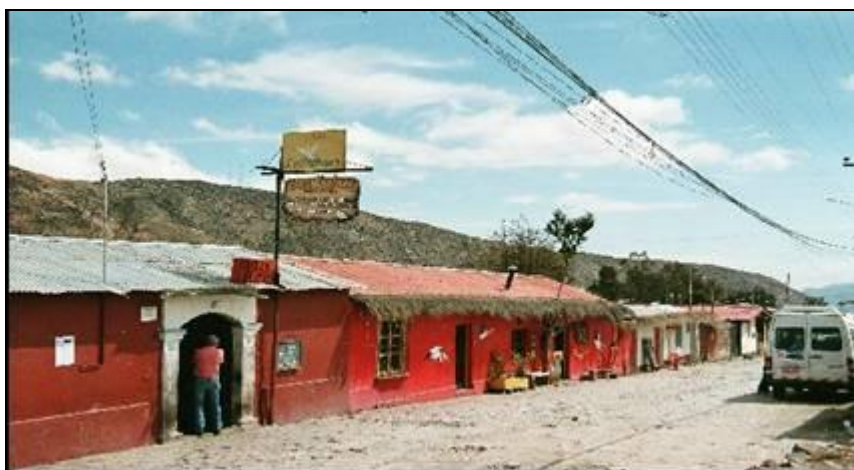
Fotografía 2-97. Restaurante, Canta Verdi, Putre
