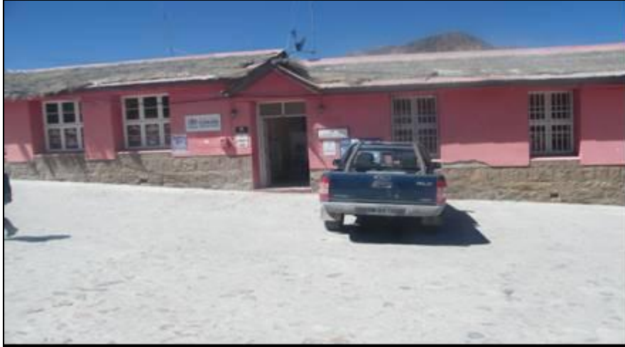
Fotografía 2-88. Oficinas CONADI, Putre
